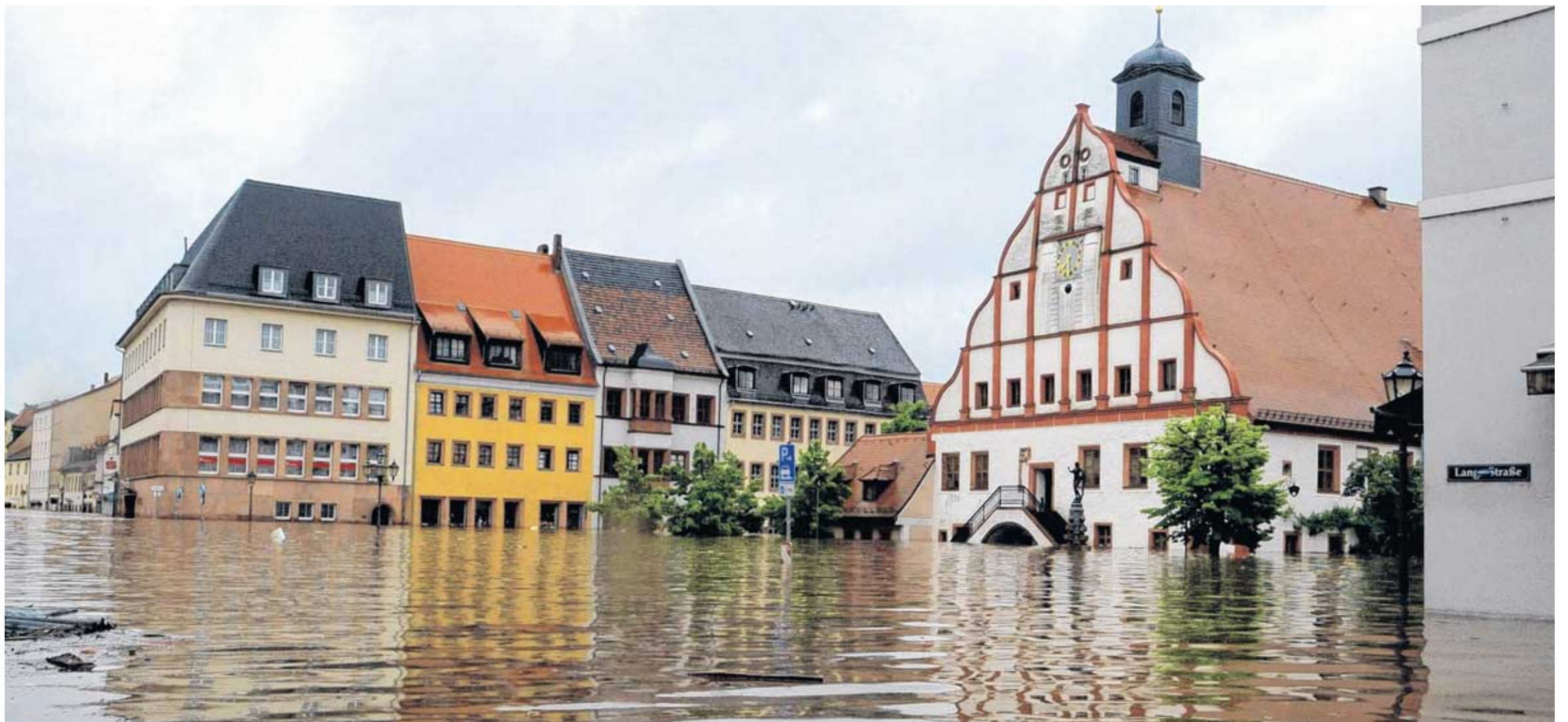
Ein Bild, das sich kaum noch von 2002 unterscheidet. Der Marktplatz in Grimma ist komplett in den Fluten versunken. Der Eingang zum Alten Rathaus ist nicht mehr zu erkennen, die benachbarten Geschäftsgebäude beklagen ähnliche Schäden wie vor elf Jahren.
